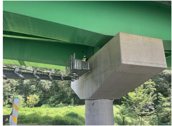
고소점검차를 이용한 근접조사
