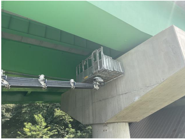
고소점검차를 이용한 근접조사
